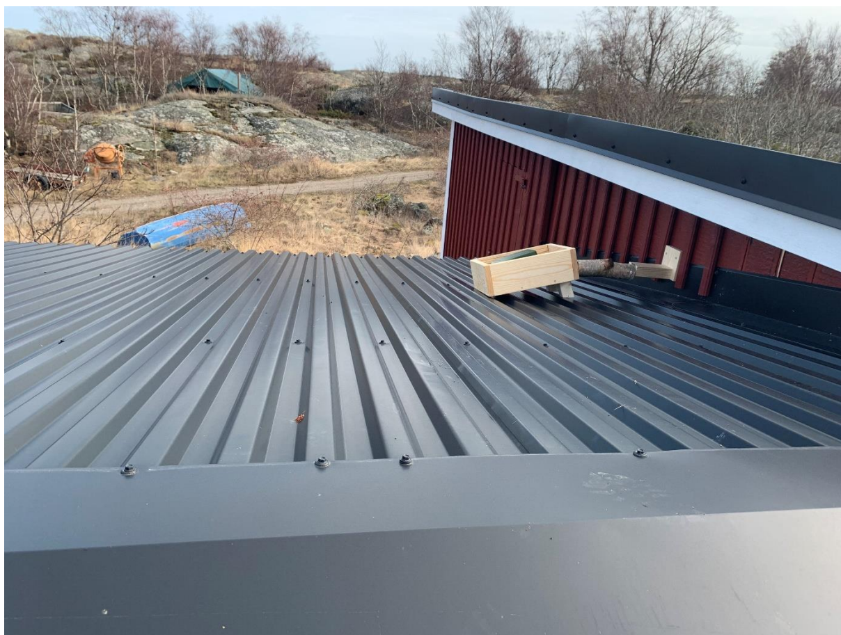
Ovan : Nocmig utrustningen på taket av fågelstationen.
